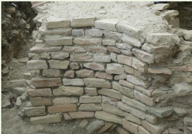
Riproposizione in epoca romanica di una tecnica costruttiva romana mediante il reimpiego di frammenti di tegole e di manubriati romani. Alternanza di due tipologie di filari: uno con alette dei frammenti di tegole in paramento e l'altro contenuto entro la prima tipologia di filare.
