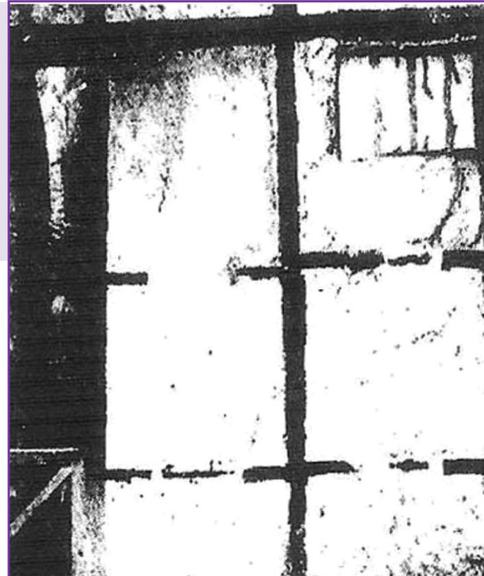
Tale tecnica costruttiva appare in tutta Europa, migliorata per la presenza di irrigidimenti diagonali, ma sempre costituita da una struttura portante in legno e da un riempimento murario scarsamente resistente [4].
